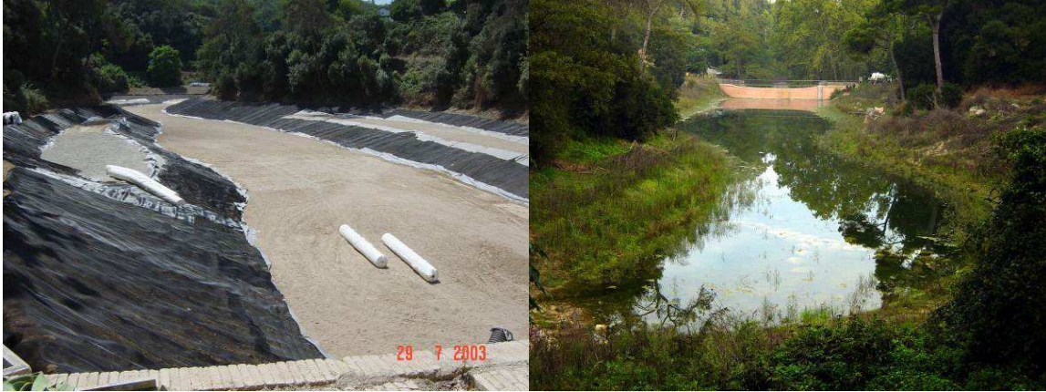
Pantà de Vallvidrera en fase de rehabilitació (esquerra) i un cop recuperat (dreta).
